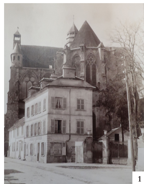
2 – Vue du transept nord et des bâtiments accolés depuis le jardin du château après les destructions de 14-18 [MAP, 0084/008/1015, août 1918].
