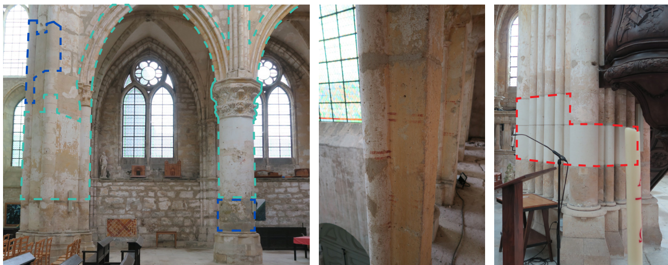
En pointillés bleus : reprises ciment. En pointillés rouges : pierres de natures différentes. En pointillés verts : décor peint. À gauche, élévation intérieure sud de la deuxième travée de nef. Au centre, détail de décor polychrome au niveau de la galerie de triforium nord de la nef. À droite, partie basse de la pile sud-est de la croisée de transept (juin 2020, photographies ACV Architecte).
