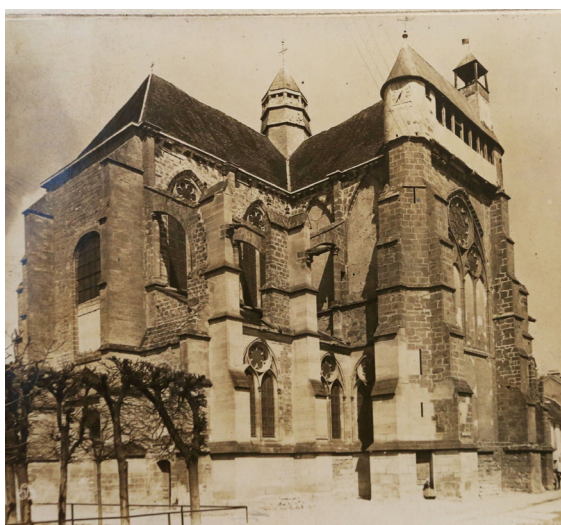
À gauche, dessin de projet de restauration des maçonneries du bas-côté sud de la nef par Maurice Ouradou, ACMH, en 1873 (MAP, cote 0082/002/2016). Au centre, photographie prise entre 1874 et 1890, vue du bas-côté sud de la nef reconstruit (MAP, cote 0081/002/0067). À droite, extrait du projet de restauration proposé par Maurice Ouradou en 1882, vue de l'élévation sud (MAP, cote 0082/002/101).
