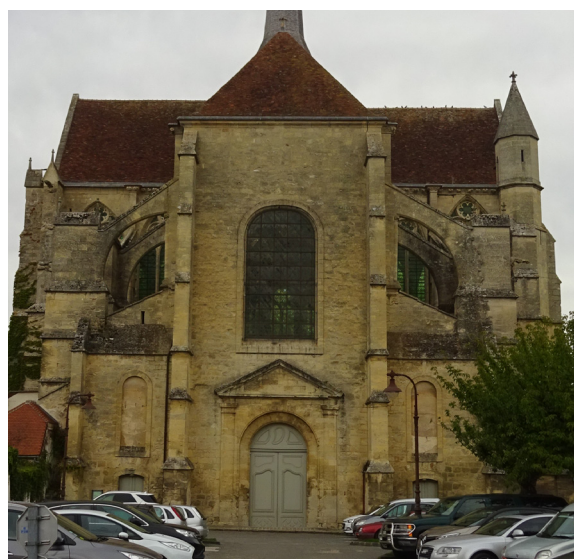
Vue de l'élévation ouest (juin 2020, photographie ACV Architecte).
