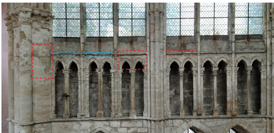
À gauche, développement de végétation au niveau de l'appui de la baie n°118 du transept sud. À droite, vue des registres supérieurs de l'élévation ouest du transept nord, ragréages ciment et coulures de rouille au niveau des appuis de baie, pulvérulences entourées en pointillés rouges et casses entourées en pointillés bleus (juin 2020, photographies ACV Architecte).
