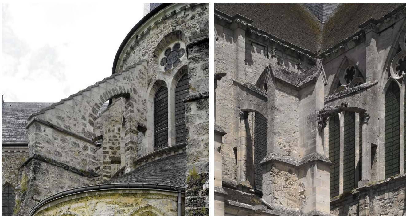
À gauche, vue des arcs-boutants au niveau du chevet de l'église abbatiale Saint-Pierre d'Orbais. À droite, vue des arcs-boutants dans l'angle entre la nef et le transept sud de l'église abbatiale Saint-Ferréol d'Essômes-sur-Marne (Mapping Gothic France).
