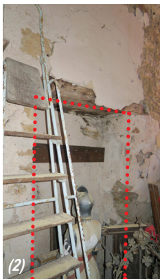
(1) vue extérieure du bâtiment adossé à la chapelle du transept nord, tirets rouges : vestiges d'un arc formeret ; points rouges : ouverture murée. (2) vue intérieure de l'ouverture murée dans le couloir en cul-de-sac. (3) vue rapprochée du piédroit gauche de l'arc. (4) vue rapprochée de ce qui semblerait être le piédroit droit de l'arc (juin 2020, photographies ACV Architecte).
