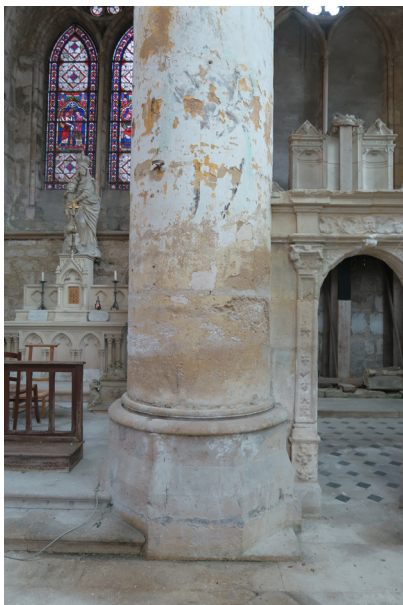
À gauche, traces d'humidité et d'efflorescences salines visibles au niveau de la pile sud-est du transept sud. À droite, vue des voûtes de l'abside, les fissures non-actives sont représentées en pointillés rouges (juin 2020, photographies ACV Architecte).
