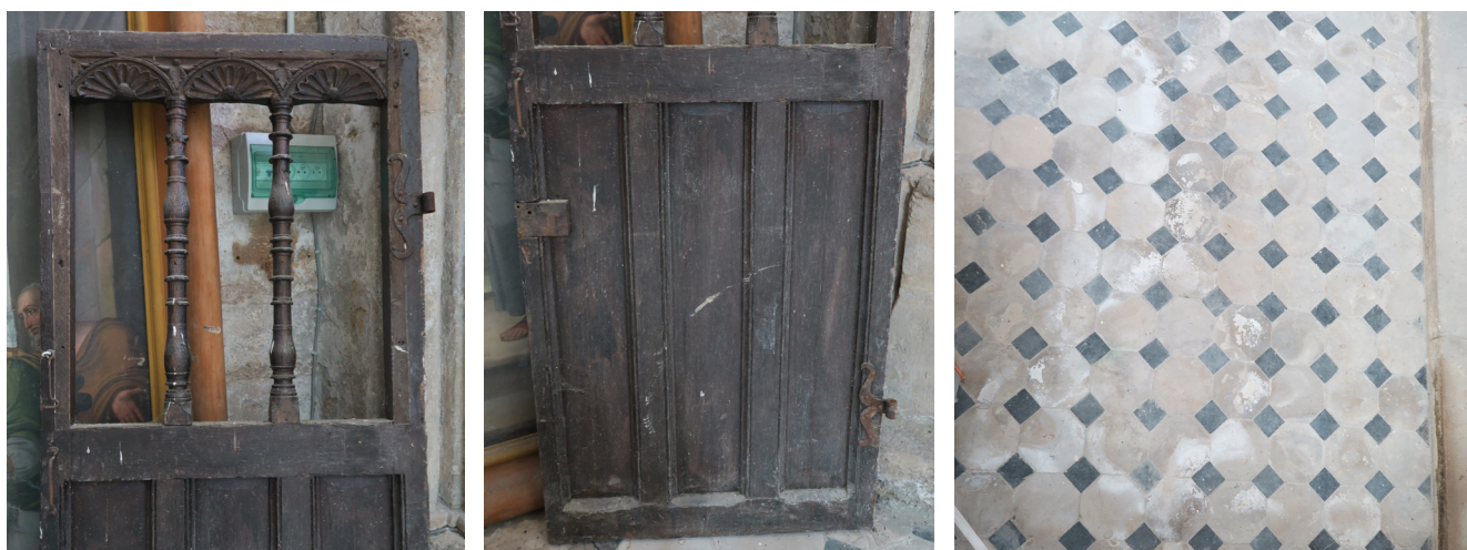
À gauche, partie haute de la porte de la clôture ouest. Au centre, partie basse de la porte de la clôture ouest. À droite, vue du sol de la chapelle du sépulcre (juin 2020, photographies ACV Architecte).
