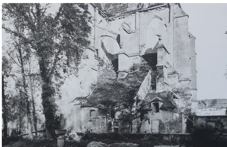
Vue des bâtiments accolés au bas-côté nord de la nef en 1918 (M. Gersuys, Médiathèque de l'Architecture et du Patrimoine, cote 0084/002/1015).
