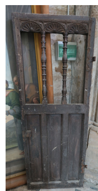
À gauche, partie supérieure de la porte de la clôture nord. Au centre, partie inférieure de la porte de la clôture nord. À droite, porte de la clôture ouest (juin 2020, photographies ACV Architecte).
