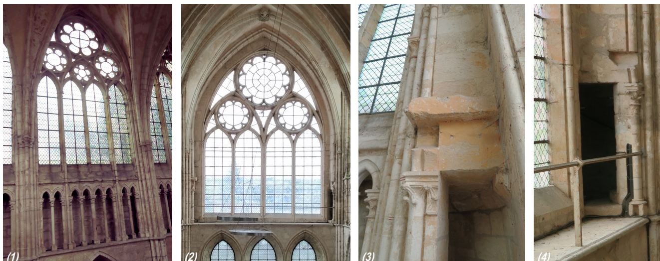
(1) baie haute d'une travée droite du chœur et concordance avec la galerie de triforium ; (2) baie haute du pignon du transept sud ; (3) et (4) traces de bûchement des arcades du triforium qui passait le long de l'élévation intérieure du bras sud de transept (juin 2020, photographies ACV Architecte).
