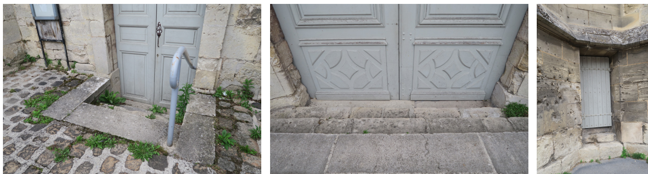
À gauche, accès secondaire nord encaissé. Au centre, accès principal à l'église. À droite, accès à la tourelle d'escalier (juin 2020, photographies ACV Architecte).
