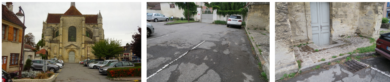
À gauche, vue du parvis et de la façade occidentale de l'église depuis l'accès sud-ouest au parking. Au centre, vue de l'extrémité du parking côté église. À droite, vue d'une grille avaloire placée en face de l'accès secondaire sud à l'église (juin 2020, photographies ACV Architecte).
