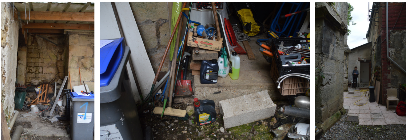
À gauche, sol en ciment et amoncellement d'objets au pied de l'élévation est de la chapelle du sépulcre. Au centre, dalle de béton armé mise en œuvre entre le contrefort de l'élévation du collatéral du transept sud et le chevet. À droite, gravier et sol recouvert de carreaux au niveau de l'élévation sud du chevet (juin 2020, photographies ACV Architecte).
