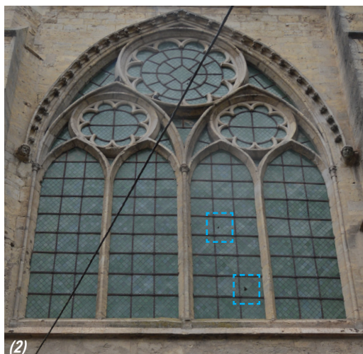
(1) baie n°124 (élévation sud de la première travée de nef). (2) baie n°116 (pignon du transept sud). (3) baie n°115 (élévation ouest du transept nord). (4) baie n°111 (élévation est du transept nord). Entourés en pointillés bleus : verres cassés. Pointillés rouges les fissures, épaufrures et joints ouverts (juin 2020, photographies ACV Architecte).
