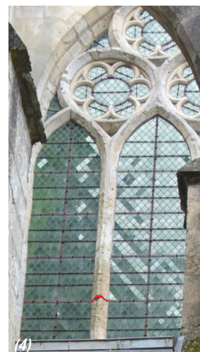
(1) baie n°124 (élévation sud de la première travée de nef). (2) baie n°116 (pignon du transept sud). (3) baie n°115 (élévation ouest du transept nord). (4) baie n°111 (élévation est du transept nord). Entourés en pointillés bleus : verres cassés. Pointillés rouges les fissures, épaufrures et joints ouverts (juin 2020, photographies ACV Architecte).
