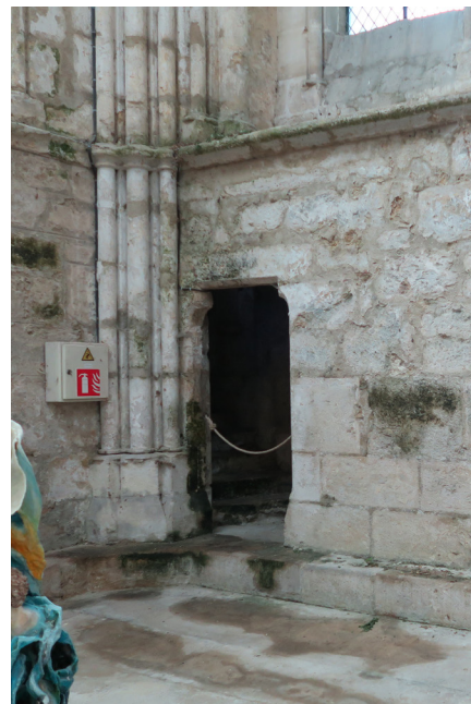
À gauche, ouverture de joint au niveau du transept sud. Au centre, développement biologique et ragréages ciment visibles au niveau des appuis de baies du chœur. À droite, joints ciment, pulvérulence du parement et développement d'algues dans l'angle sud-ouest du transept sud (juin 2020, photographies ACV Architecte).
