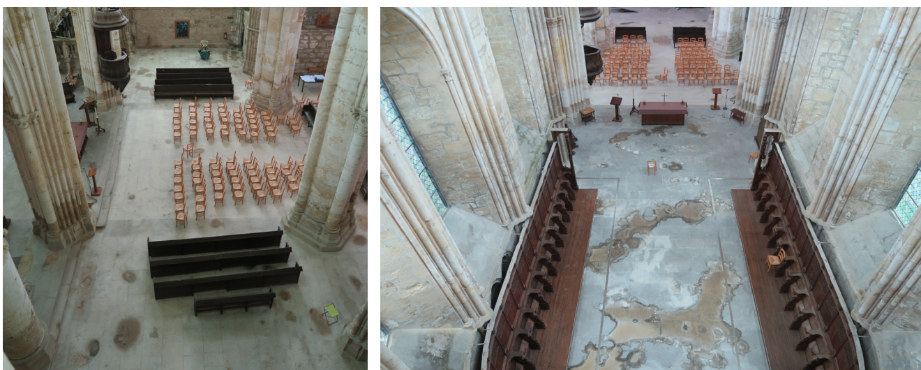
À gauche, vue du vaisseau principal du transept depuis le bras nord. À droite, vue du dallage du sanctuaire (juin 2020, photographies ACV Architecte).
