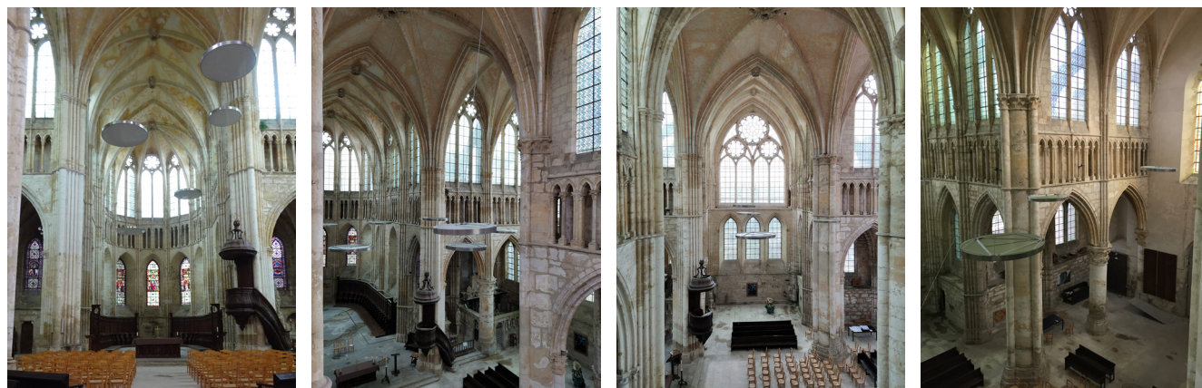
De gauche à droite : vue du chœur depuis la nef, vue de la croisée de transept depuis la nef, vue du bras sud de transept depuis le bras nord de transept, vue de l'élévation sud de la nef depuis la croisée de transept (juin 2020, photographies ACV Architecte).
