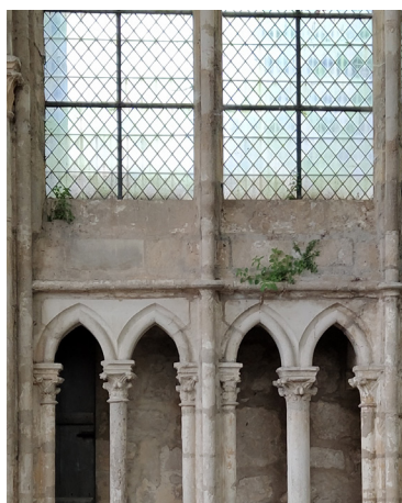
À gauche, développement de végétation au niveau de l'appui de la baie n°118 du transept sud. À droite, vue des registres supérieurs de l'élévation ouest du transept nord, ragréages ciment et coulures de rouille au niveau des appuis de baie, pulvérulences entourées en pointillés rouges et casses entourées en pointillés bleus (juin 2020, photographies ACV Architecte).
