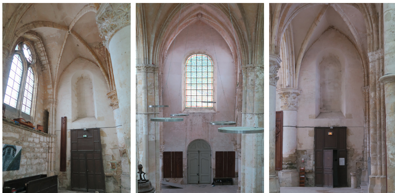
À gauche, élévation ouest du bas-côté sud de la nef. Au centre, élévation ouest du vaisseau central de la nef. À droite, élévation ouest du bas-côté nord de la nef (juin 2020, photographies ACV Architecte).
