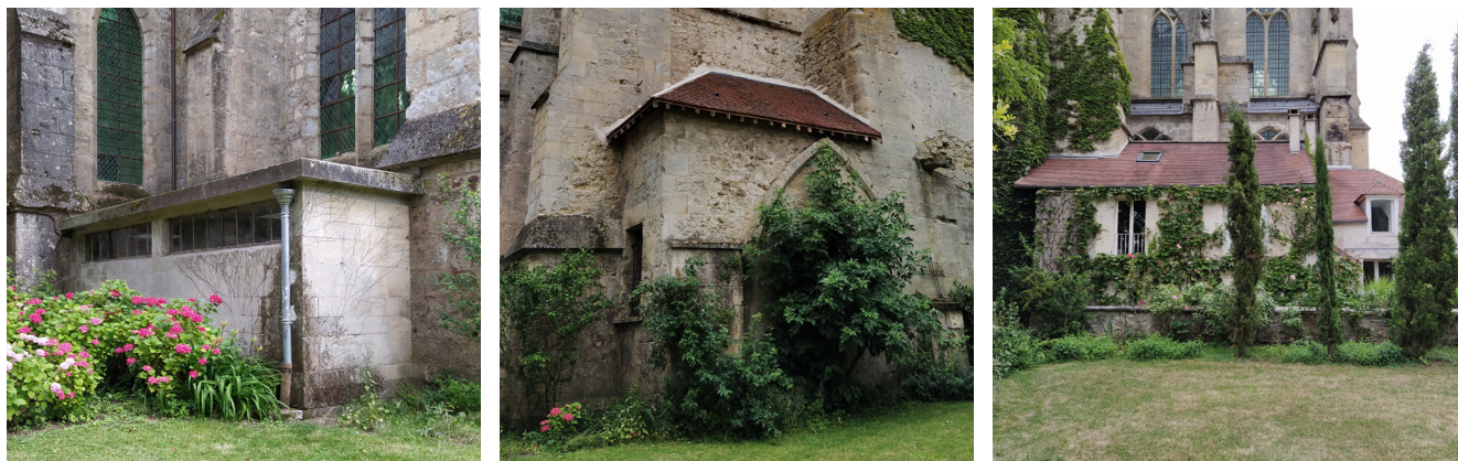
À gauche, vue de la sacristie, dans l'angle entre le chevet et le transept nord. Au centre, édicule adossé au pignon du transept nord. À droite, vue des bâtiments adossés au bas-côté nord de la nef (juin 2020, photographies ACV Architecte).
