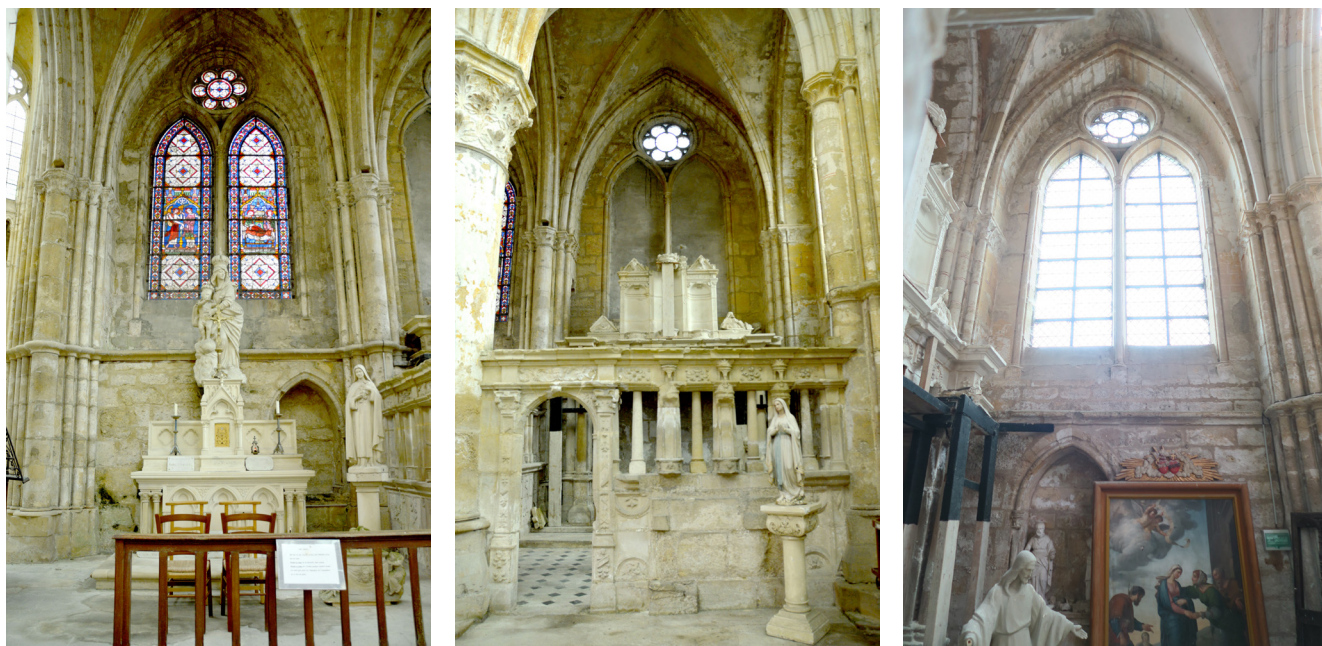
À gauche, élévation intérieure est de la chapelle nord du bas-côté du transept sud. Au centre, élévation intérieure est de la chapelle sud du bas-côté du transept sud. À droite, élévation intérieure sud du bas-côté du transept sud (juin 2020, photographies ACV Architecte).
