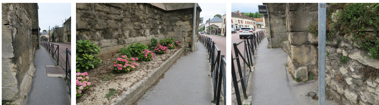
À gauche, trottoir longeant le bras sud de transept vu depuis le sud. Au centre, jardinière installée entre les deux contreforts du pignon sud du transept. À droite, trottoir longeant le bras sud de transept vu depuis l'est (juin 2020, photographies ACV Architecte).
