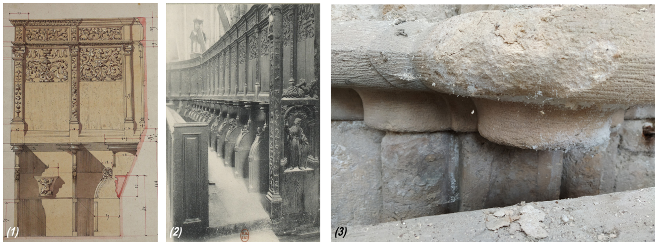
(1) 1882, détail des stalles, Maurice Ouradou, ACMH (MAP, cote 0082/002/2016). (2) 1913, carte postale des stalles (BnF, cote VE-377 (8)-4). (3) détail d'une colonne troquée pour permettre l'installation des stalles (juin 2020, photographie ACV Architecte).
