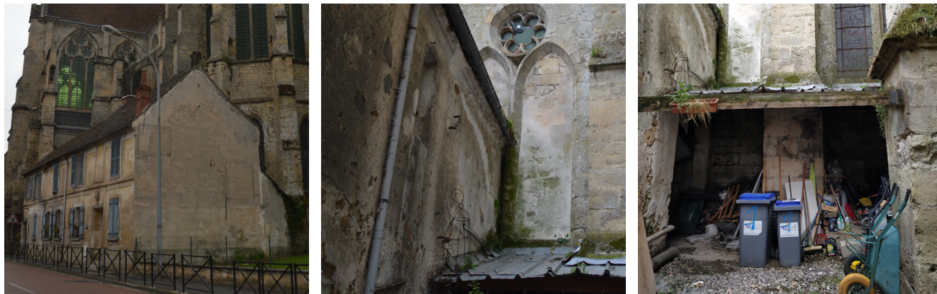
À gauche, vue du bâtiment situé dans l'angle entre le chevet et le transept sud. Au centre, détail du pignon adossé sur la baie murée de la chapelle du sépulcre. À droite, détail de la couverture en appentis installée entre les contreforts (juin 2020, photographies ACV Architecte).
