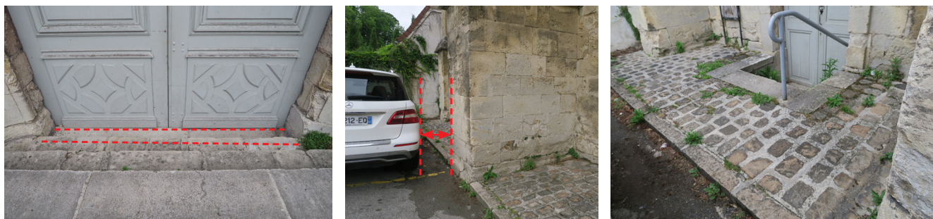
À gauche, vue extérieure de l'embranchement donnant sur la porte d'accès principale. Au centre, largeur de passage libre lorsqu'une voiture est garée devant l'accès secondaire nord. À droite, vue de l'accès secondaire nord et de la main-courante en ferronnerie (juin 2020, photographies ACV Architecte).
