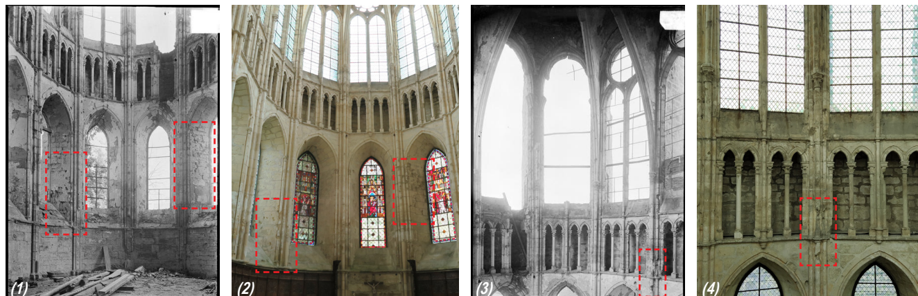
(1) et (2) impacts de mitrailles de la Première Guerre mondiale conservés dans le parement intérieur des élévations actuelles. (3) et (4) impacts de mitrailles de la Première Guerre mondiale conservés dans le parement intérieur des élévations actuelles (photographies dommages de guerre Base mémoire, photographies actuelles ACV Architecte).
