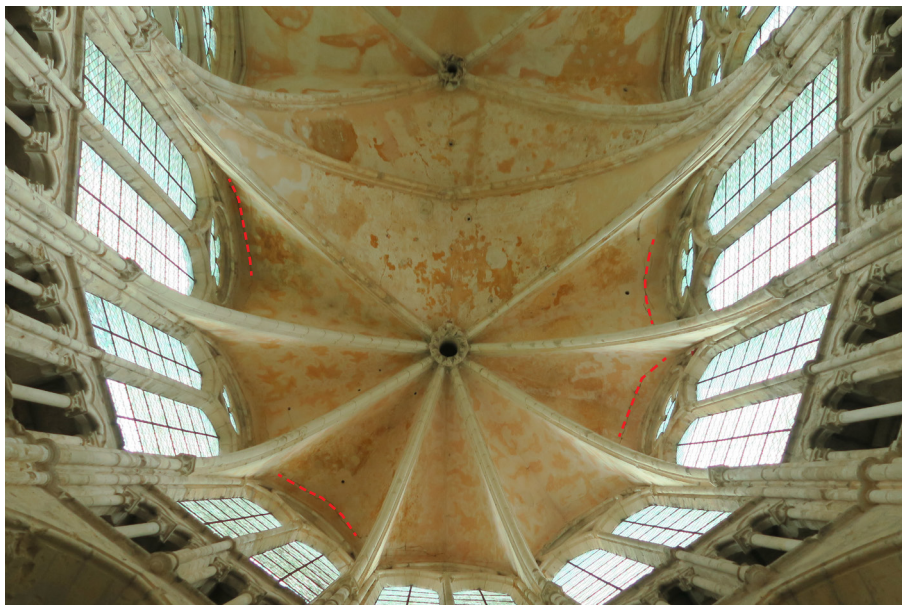
À gauche, traces d'humidité et d'efflorescences salines visibles au niveau de la pile sud-est du transept sud. À droite, vue des voûtes de l'abside, les fissures non-actives sont représentées en pointillés rouges (juin 2020, photographies ACV Architecte).
