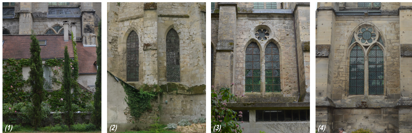
(1) vue d'une baie du bas-côté nord de la nef. (2) vue des deux baies de l'abside. (3) vue de la baie de la chapelle nord du transept nord (4) vue de la baie ouest du bas-côté sud de la nef (juin 2020, photographies ACV Architecte).
