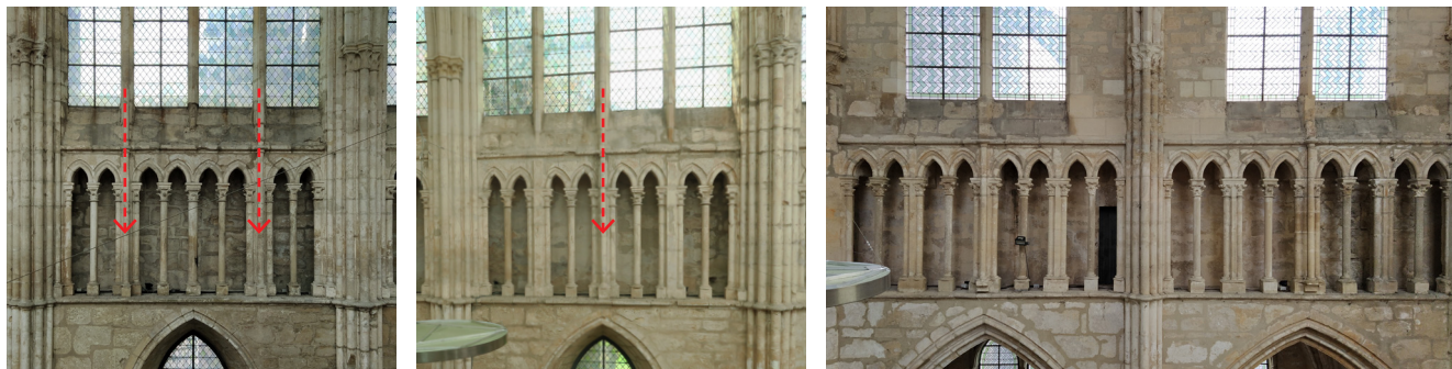
À gauche, élévation intérieure sud de la première travée droite de chœur. Au centre, élévation intérieure nord de la première travée droite de chœur. À droite, élévation intérieure sud de la nef (juin 2020, photographies ACV Architecte).
