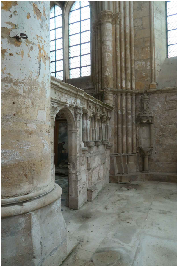
④ vue de la clôture ouest de la chapelle et du bénitier
