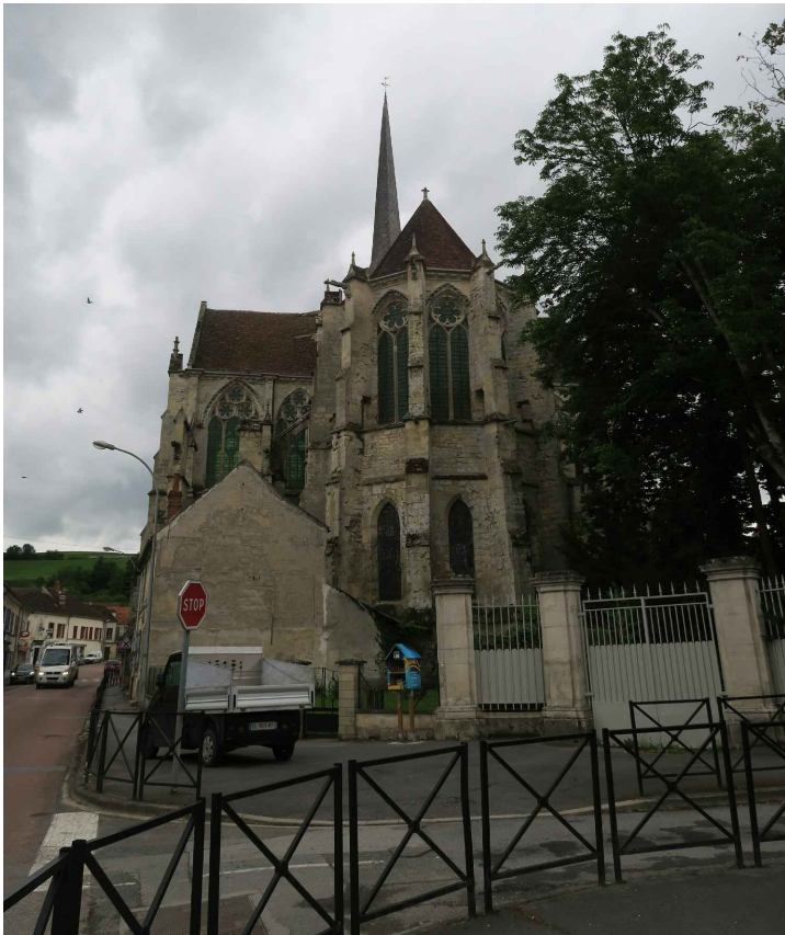
⑦ élévation extérieure est depuis l'avenue du Général de Gaulle
