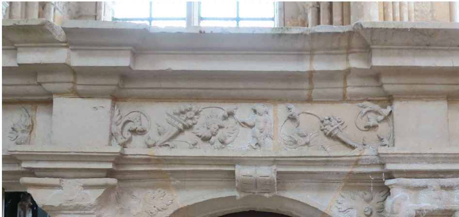
a. frise de putti, rinceaux et cornes d'abondances sculptés au niveau du linteau de la porte d'accès nord
