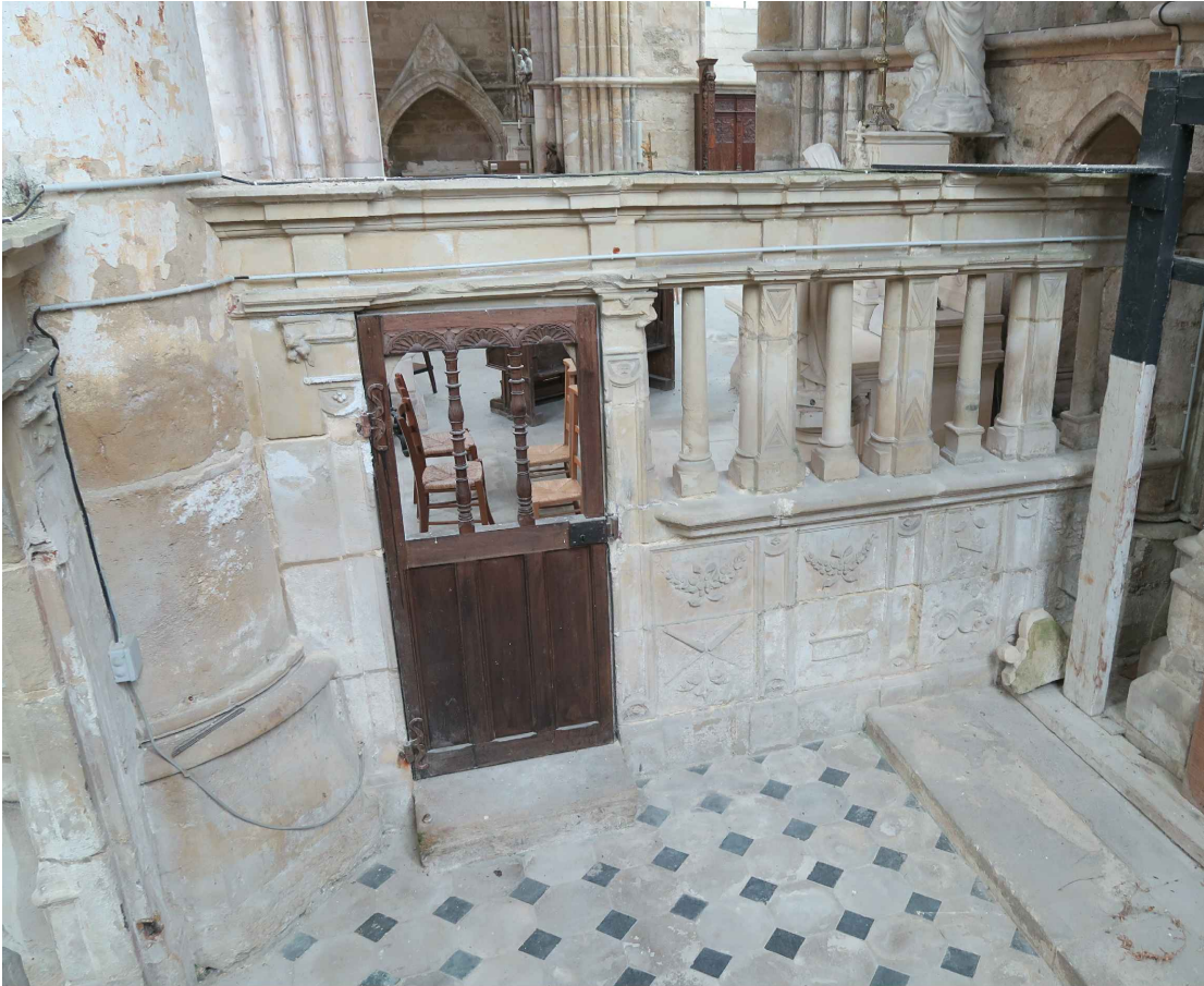
⑪ élévation intérieure de la clôture nord
