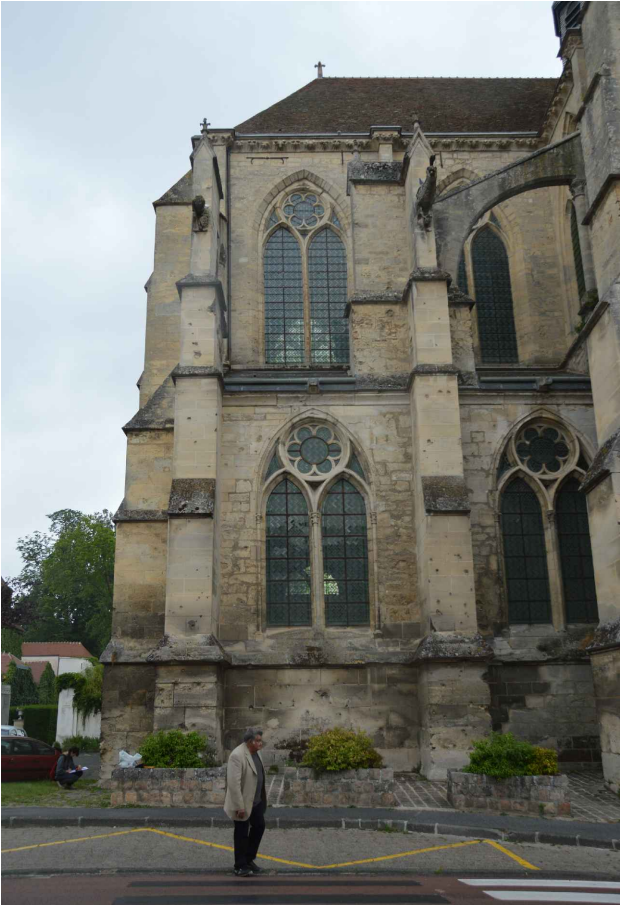
⑪ élévation extérieure sud depuis l'avenue du Général de Gaulle
