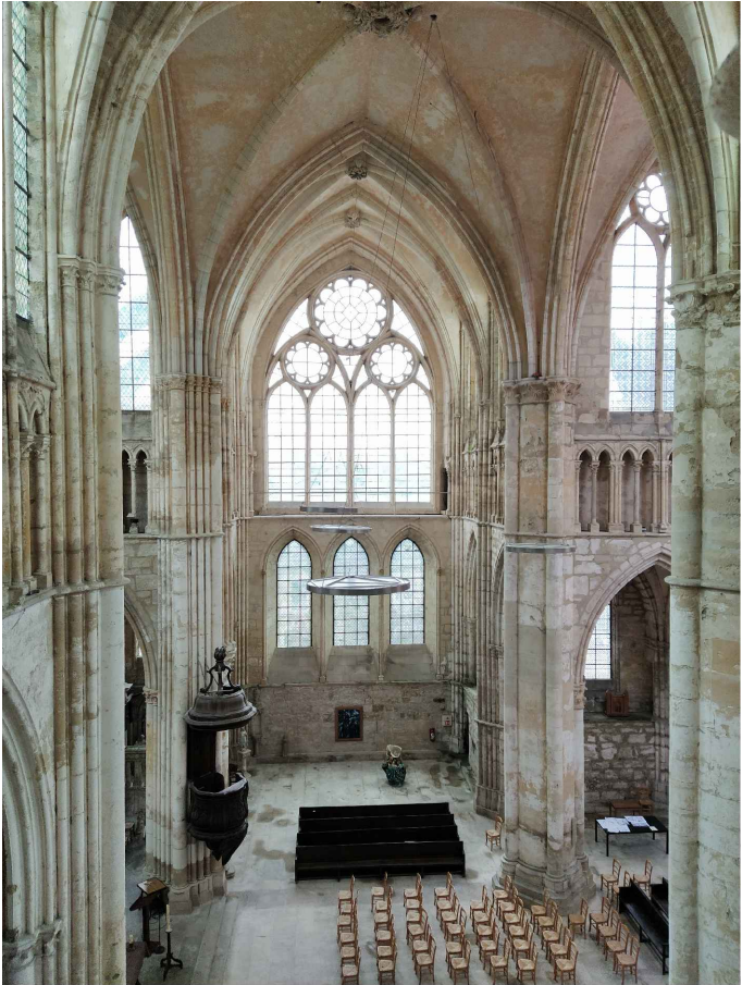
⑤ vue générale intérieure depuis le triforium du transept nord
