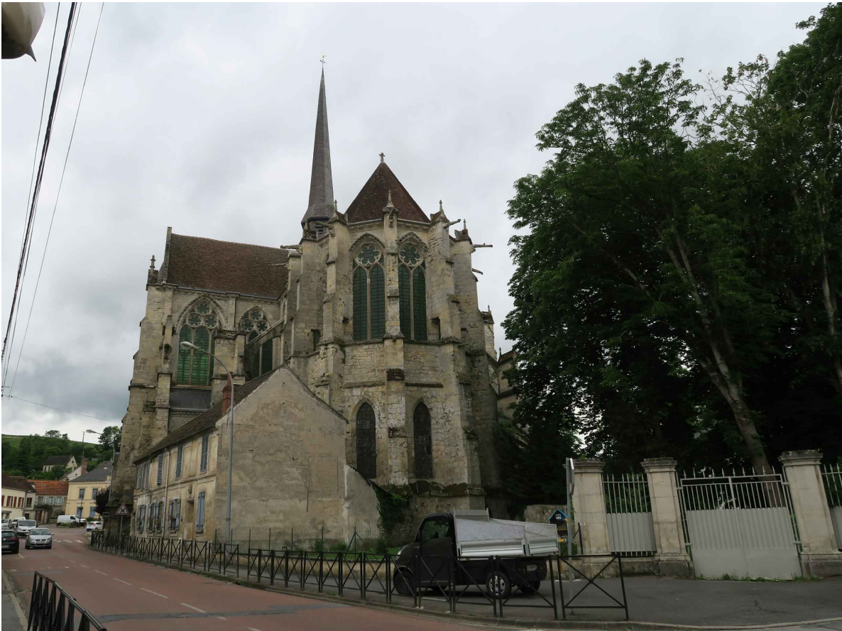
② vue générale extérieure depuis l'avenue du Général de Gaulle
