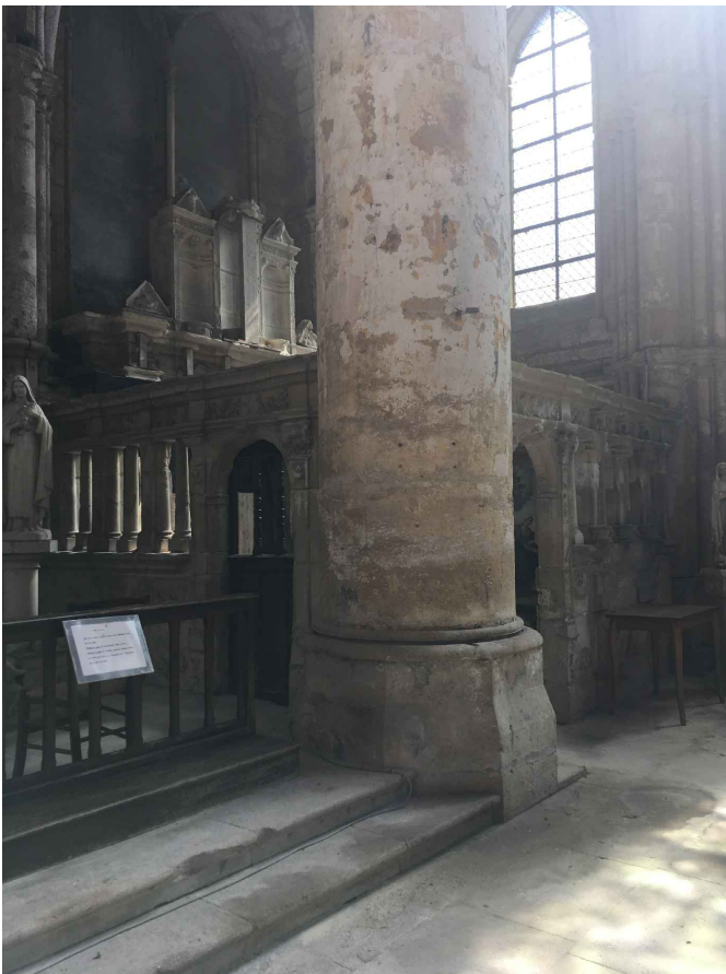
③ vue de la chapelle du sépulcre depuis le transept sud
