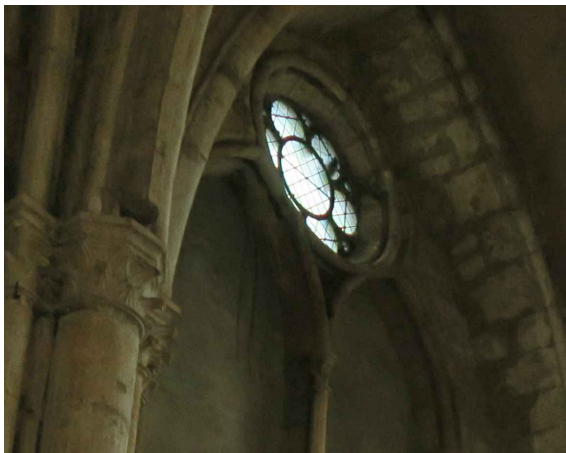
1. vue intérieure du remplage muré
