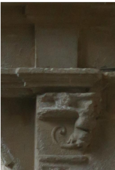
d. chapiteau de pilastre sculpté en encadrement de la porte côté intérieur
