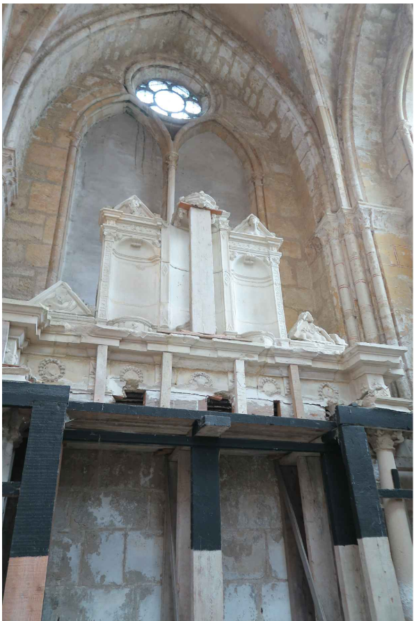
⑦ vue du retable soutenu par des piliers de bois
