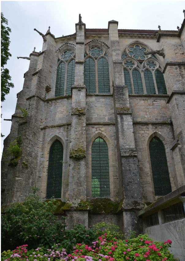
⑧ élévation extérieure nord depuis la parcelle mitoyenne privée
